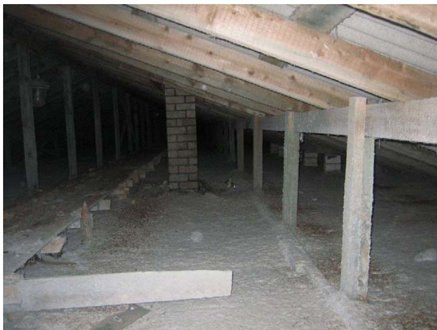
III korruse lagi on soojustatud puistevillaga
