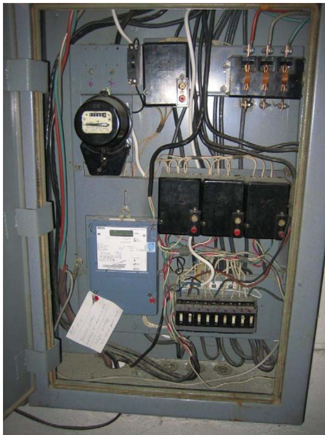
Elektrikilpide automaatika ja juhtmestik on hoone ehitusaegne.
