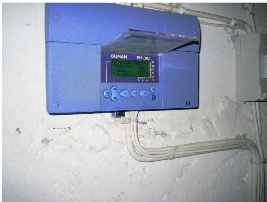
Soojussõlme juhtautomaatika. Võimaldab seadmete aegjuhtimist ja määrata paindlikult küttegraafikut.
