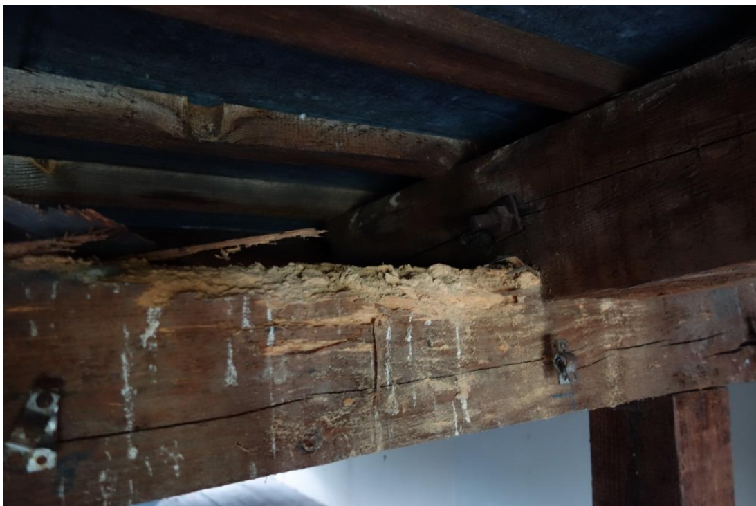
Foto 14 Näide pehastunud puidust – põhjapoolse pööninguosa keskne toolvärgi tala.
