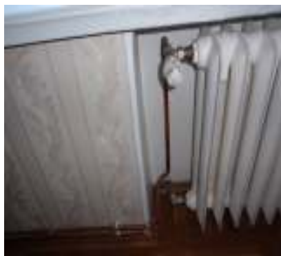
Tüüpiline küttekeha. Asukoht. Termostaat.
