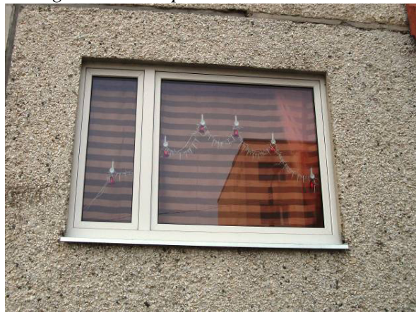
Paigaldatud uus pakettaken
