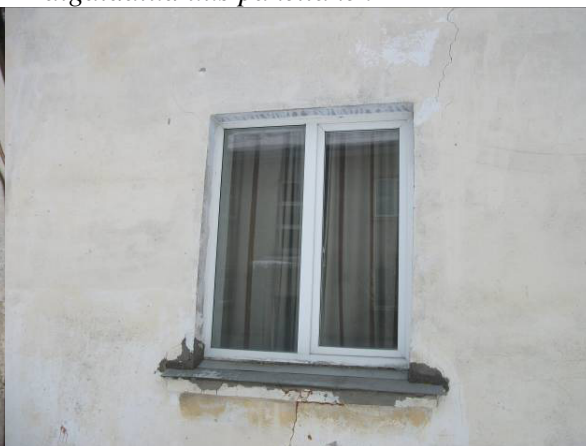
Paigaldatud uus pakettaken
