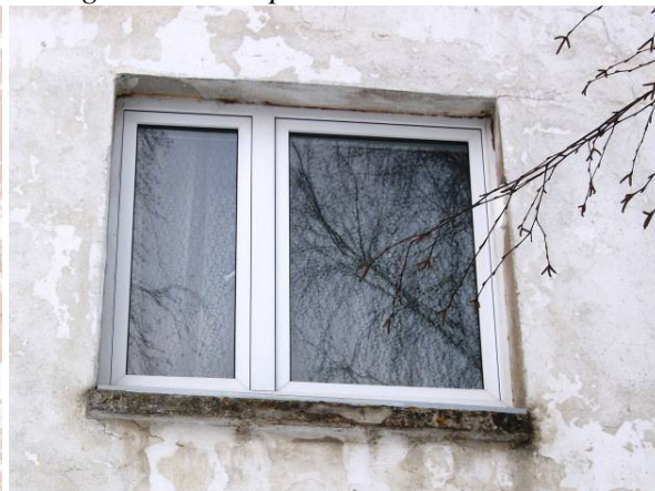
Paigaldatud uus pakettaken
