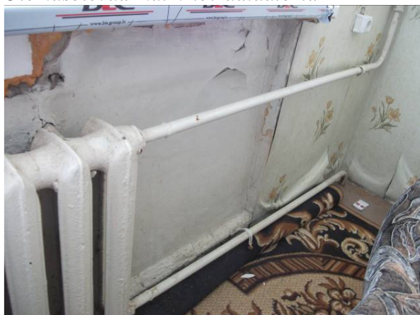
Olemasolevad malmribiradiaatorid
