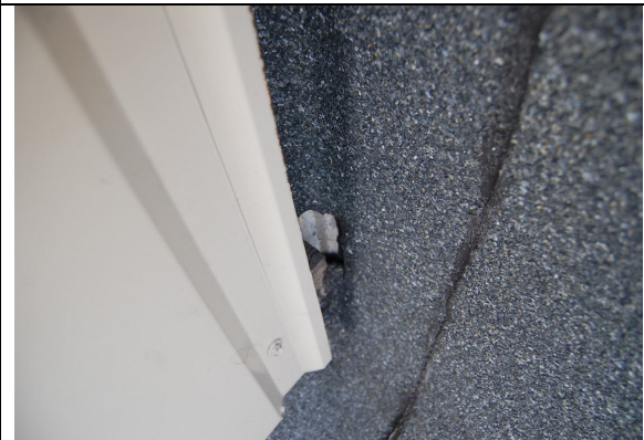
Foto nr. 28. Ebahermetilised kohad katusel.
