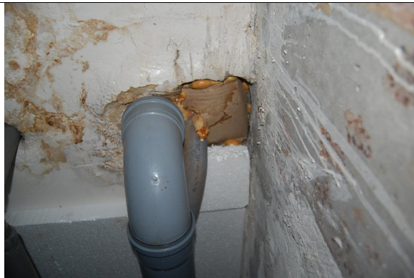
Foto nr. 21. Vee- ja kanalisatsioonitorude püstakud. Konstruktsioonide kommunikatsioonide läbiviigid ei vasta tuleohutuse normidele.
