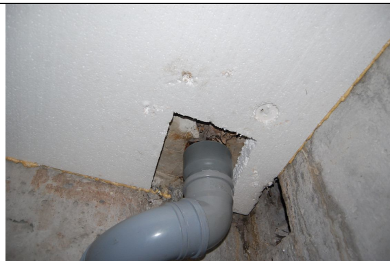
Foto nr. 24. Kanalisatsiooni püstakud on vanad ja amortiseerunud.
