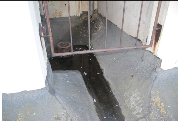
Foto nr. 15. Liftšahide sadeveetorud on vanad. Puuduvad normaalsed kalded.
