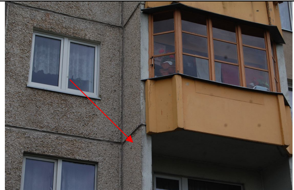
Foto nr. 6. Raudbetoonpaneelidel on kahjustatud.
