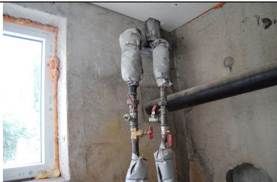
Foto nr. 21. Vee- ja kanalisatsioonitorude püstakud. Konstruktsioonide kommunikatsioonide läbiviigid ei vasta tuleohutuse normidele.
