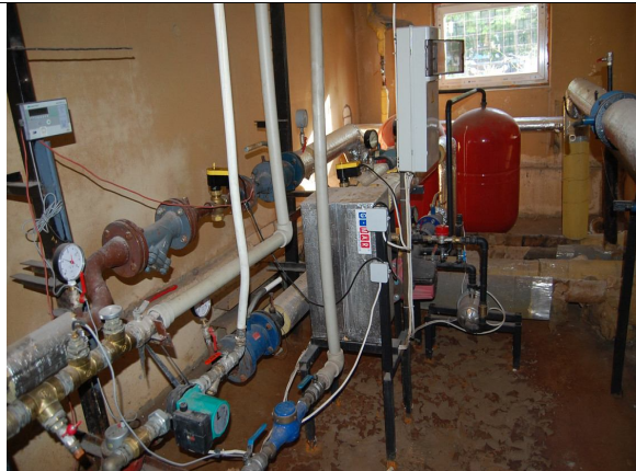
Foto nr. 17. Soojussõlm.
