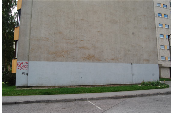
Foto nr. 9. Fassaadid osaliselt soojustatud.
