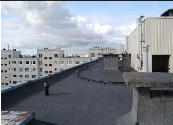
Foto nr. 15. Liftšahide sadeveetorud on vanad. Puuduvad normaalsed kalded.
