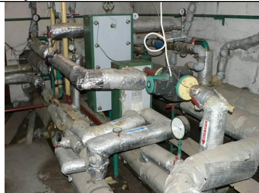
Foto nr. 12 Soojussõlm
